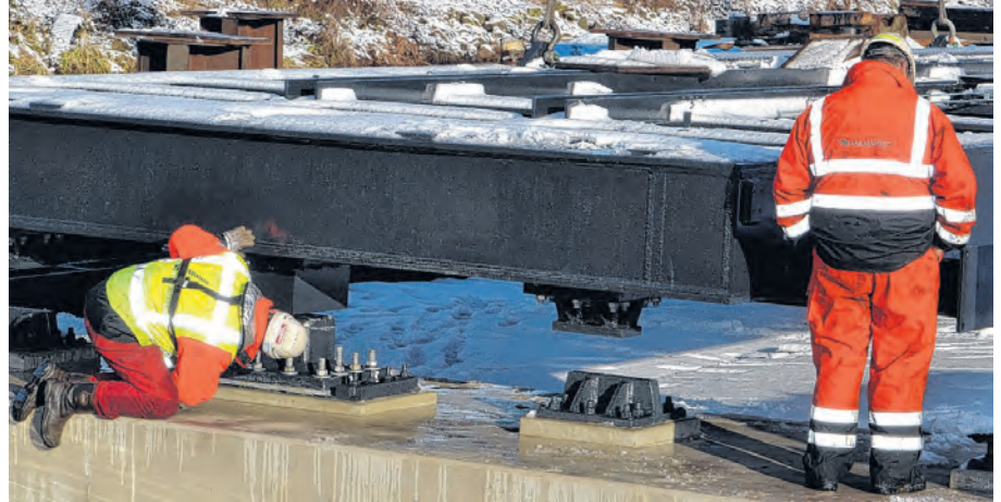
Am Freitagvormittag wurde das erste von zwei 53 Meter langen und jeweils 140 Tonnen schweren Bauteilen für die neue Eisenbahn-Drehbrücke über den Coevorden-Almelo-Kanal im Europark Coevorden auf dem Drehlager montiert.
